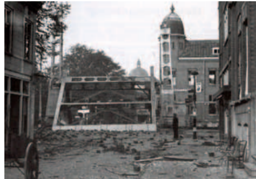
De totaal vernielde Veestraatbrug. (Collectie Henk van Dijk)
