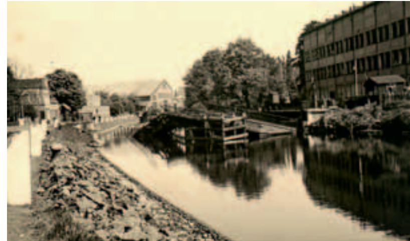
De restanten van de trambrug ter hoogte van de Vlisco. (Collectie Henk van Dijk)
