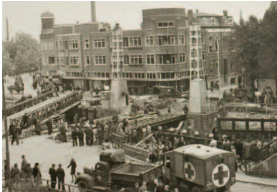
Foto genomen vanaf hotel West-Ende. De reparatie van de Veestraatbrug is in volle gang. Links is de baileybrug goed te zien. (Collectie Berry Wijnen)
