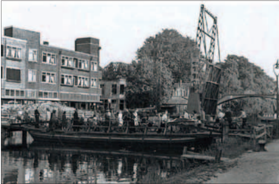
Tijdens de reparatie van de Veestraatbrug werd ter hoogte van de Watermolenwal gebruik gemaakt van een schipnoodbrug. (Collectie Henk van Dijk)
